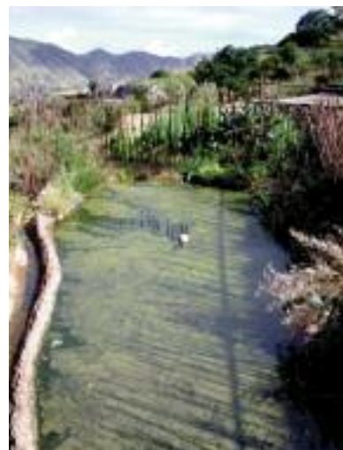
Estación depuradora del albergue de Bólico.
